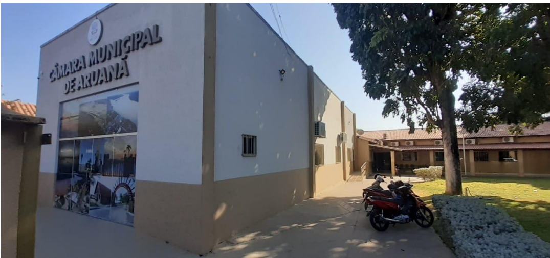
Foto 02 – Vistas das Fachadas da Câmara dos Vereadores do Município de Aruanã-GO.
