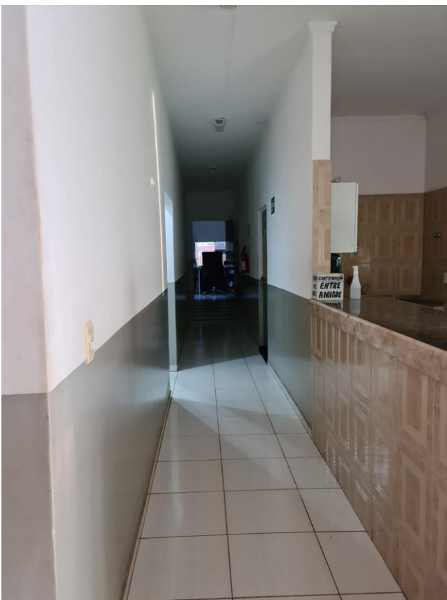
Foto 10 – Imagem de circulação interna a ser reformada.
