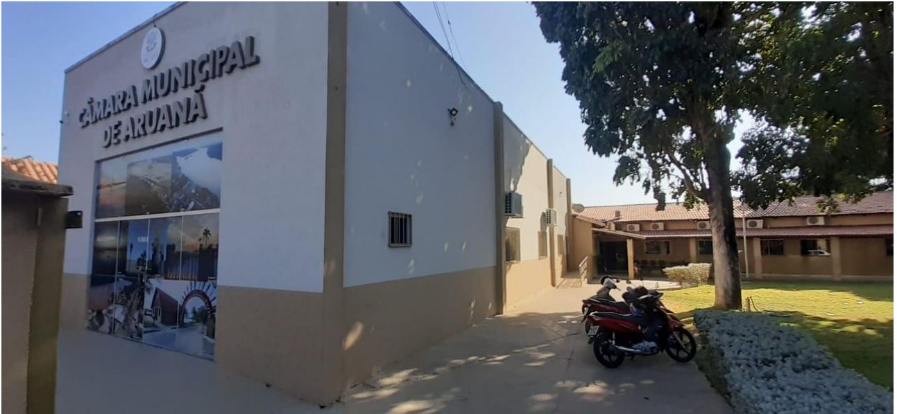
Foto 03 – Imagem das fachadas a serem revitalizadas.
