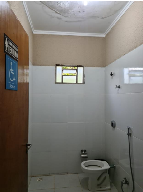
Fotos 12 e 13 – Imagens dos banheiros masculino e feminino que serão adaptados para PNE, substituídos os forros de gesso do teto e instaladas bancadas e cubas nos lavatórios.
