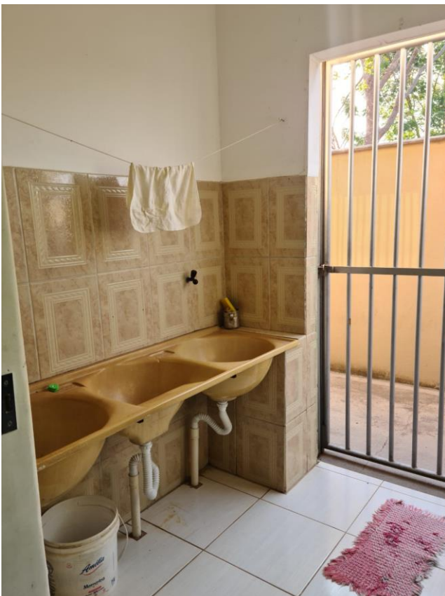
Foto 17 – Imagem da área de serviço a ser reformada.
