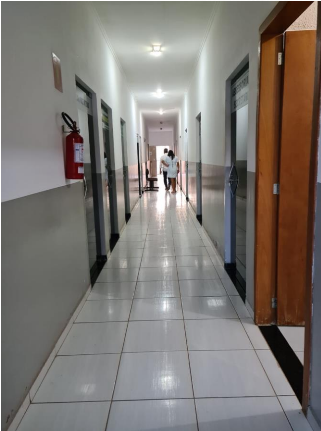
Foto 09 – Imagem de circulação interna a ser reformada.
