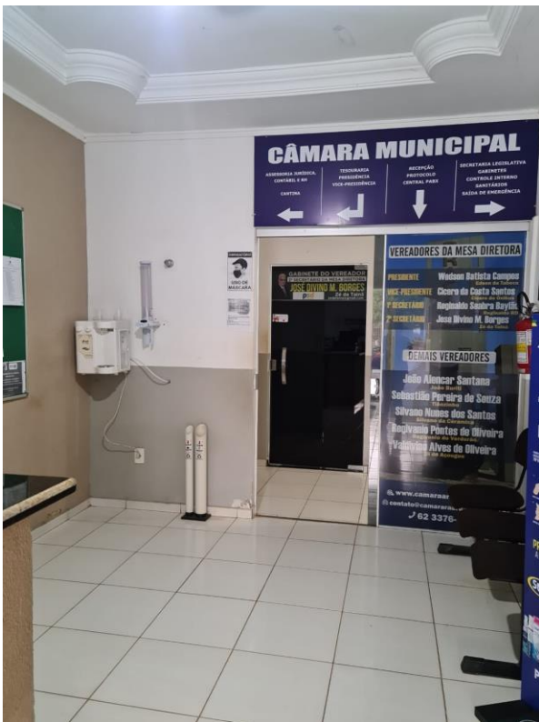
Foto 06 – Imagem da recepção a ser reformada.
